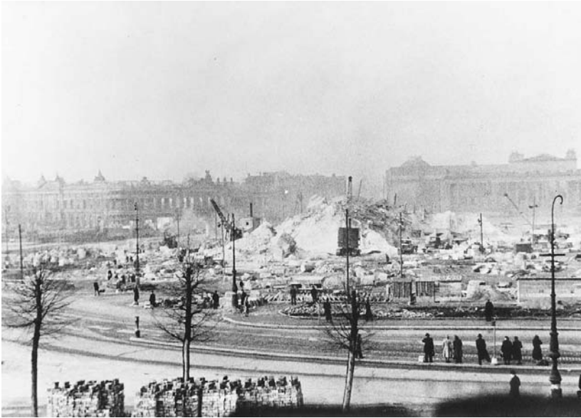
Figure 30. Demolition of the imperial palace, East Berlin, 1951. Bildarchiv Preussischer Kulturbesitz.
