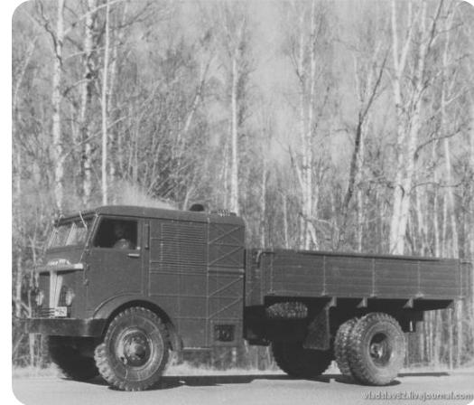
Двигатель работает на любом топливе (источнике тепла)
